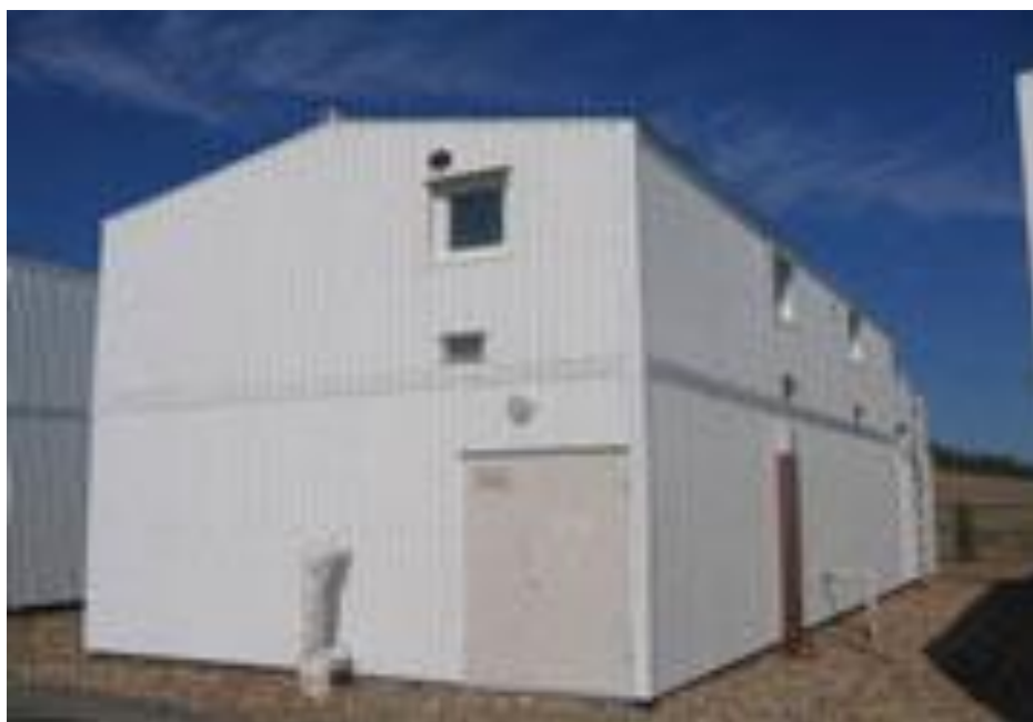
Рис.12.1. Внешний вид очистных сооружений «Биоресурс»
